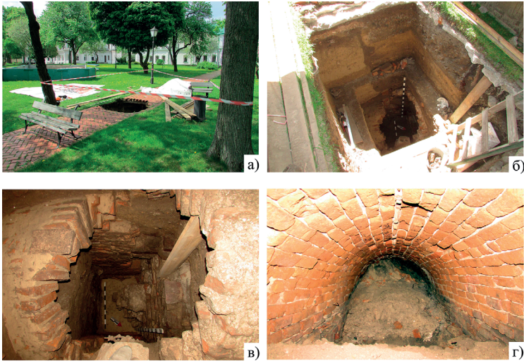
Рис. 4. Фотографії провалу 2021 р. (а), розкопу на його місці (б) і фрагменту підземної споруди, що відкрилася (в,г).
